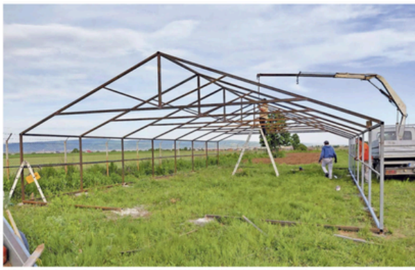
Die Jugendlichen werden das grosse Gewächshaus schon bald fertigstellen.
